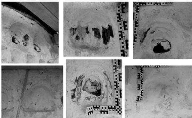
Рис. 3. Типичное состояние черепков при фиксации после установки коренных лесов. (Фото автора).
